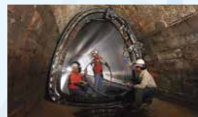
美国的管道翻新工程施工情形
