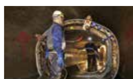
下水道管道翻新工法及材料
