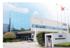
积水保力马科技(上海)有限公司
