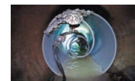
下水道管道翻新施工法
