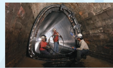
美国的管道翻新工程施工情形
