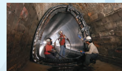
美国的管道翻新工程施工情形
