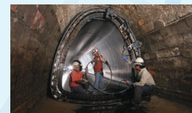
美国的管道翻新工程施工情形
